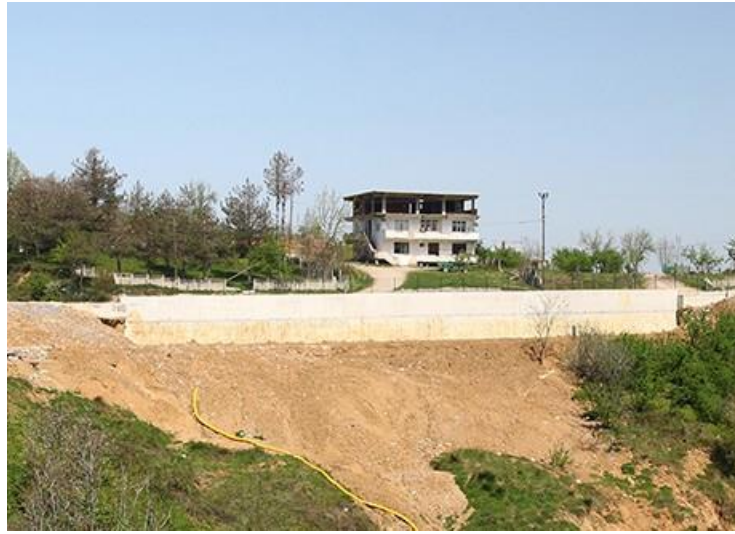
Şekil 10. İmalat sonu konsol duvarın karşı yamaçtan görünümü
