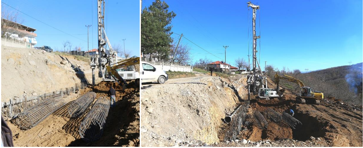
Şekil 9. Kazık delgi işlemi ve donatıların hazırlanması
